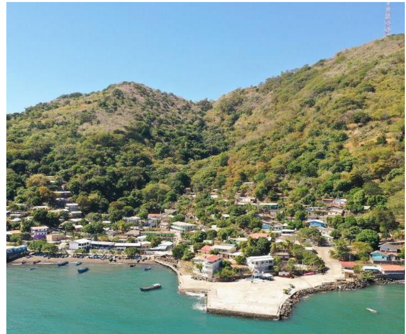
Tejido edificado continuo insular condicionado por riesgo, municipio de Meanguera del Golfo. MARN 2019
